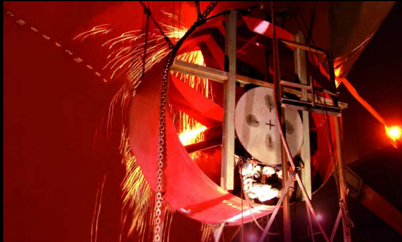
Eine einzigartige Energiesparlösung von Becker Marine Systems: Durch das effiziente Antriebssystem Becker Mewis Duct konnten seit der Einführung weltweit bereits mehr als zwölf Millionen Tonnen CO 2 -Emissionen eingespart werden.
